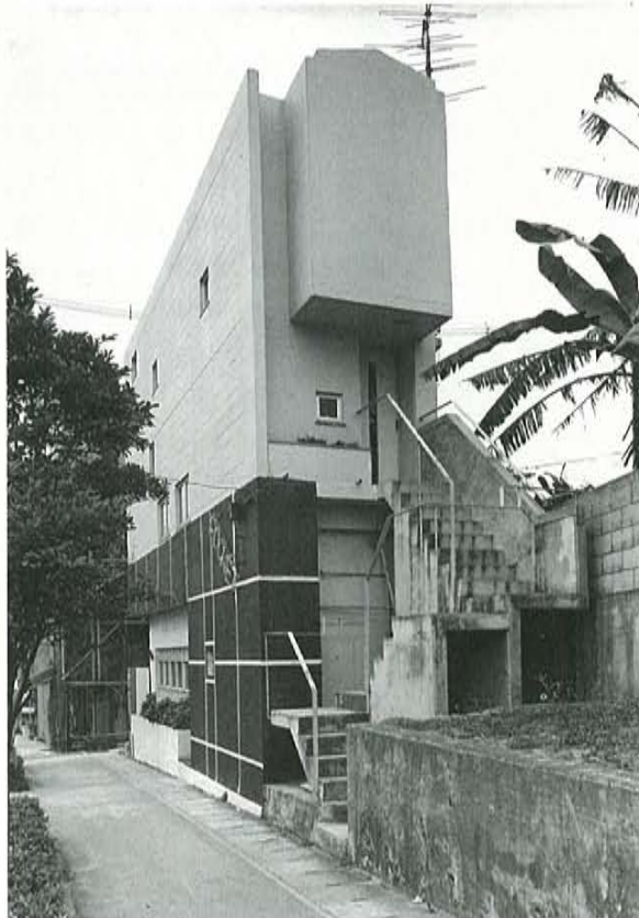
南側外観 1階は既存
