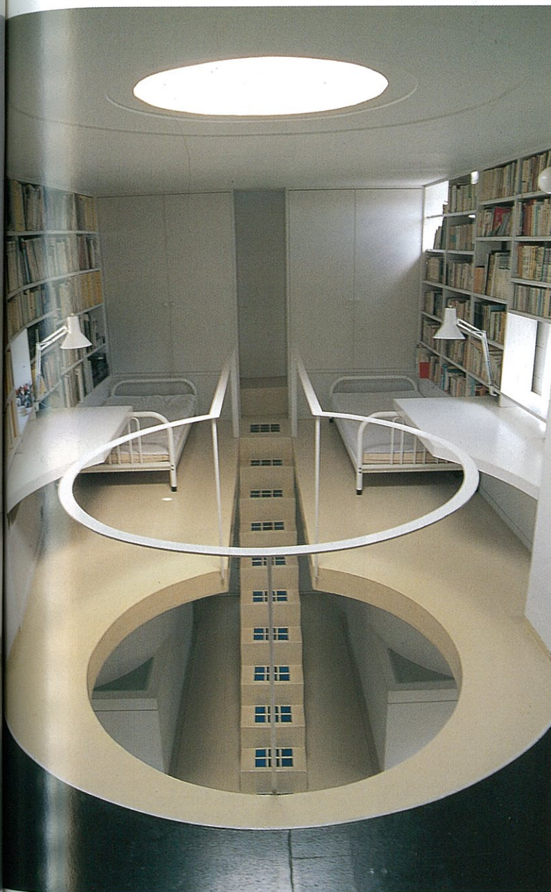
窓の少ない分、上階には天窓があり、吹き抜けを通じて十分な光が下の階にも届く。屋上に土を載せて照り返しを防ぎ、建物を冷やす工夫がされている
