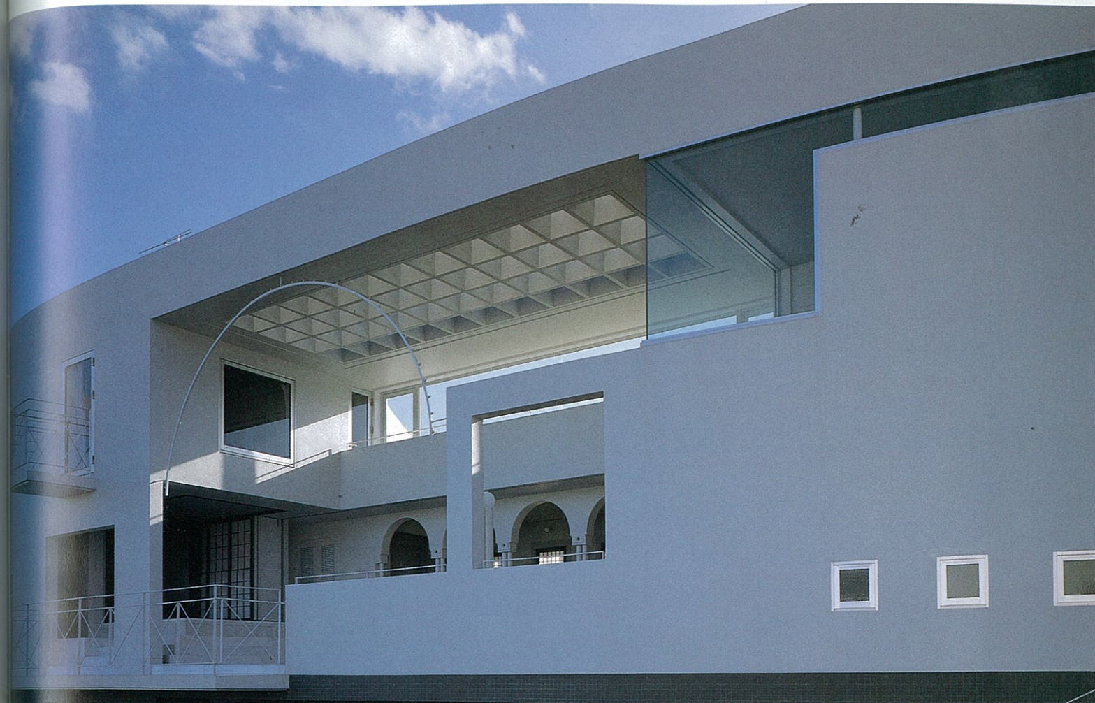
道路に面する北側全景
