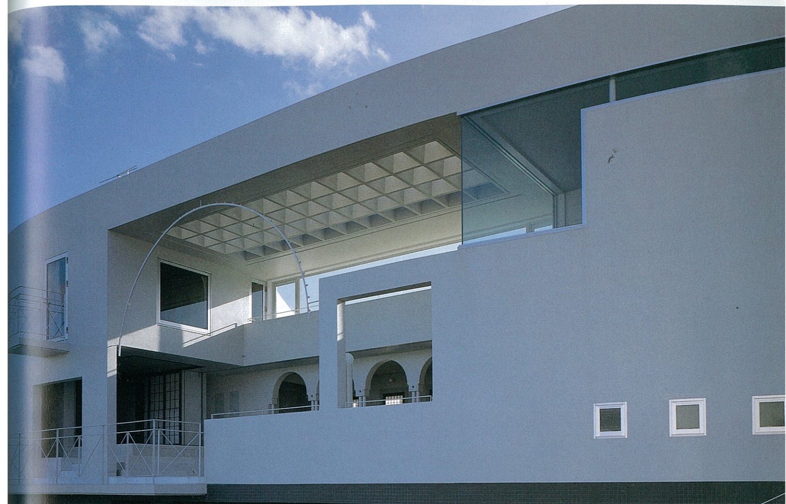
道路に面する北側全景
