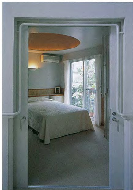
ホールより寝室方向を見る。出入口部分には手摺がゲート状に回されている。扉は車椅子でも使いやすいように2枚引きで両側に引き込まれる
