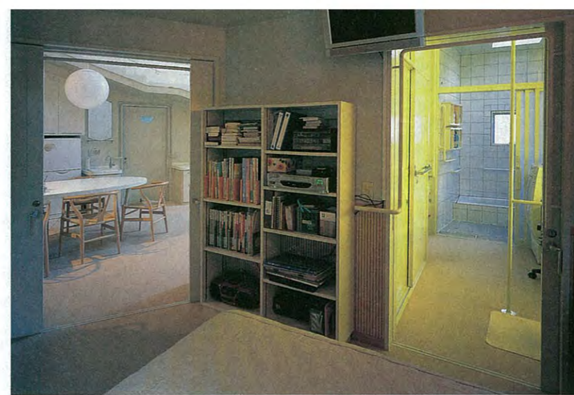
寝室から見たダイニング・キッチン(左)とトイレ(右)。横から縦へと続く手すりは目立たないように上部もそのまま連続させた。スチールの手すりを現場で溶接した
