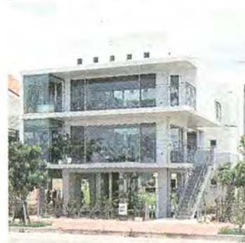
外観。海に面した西に開口を大きく取った。1階はピロティ・駐車場
