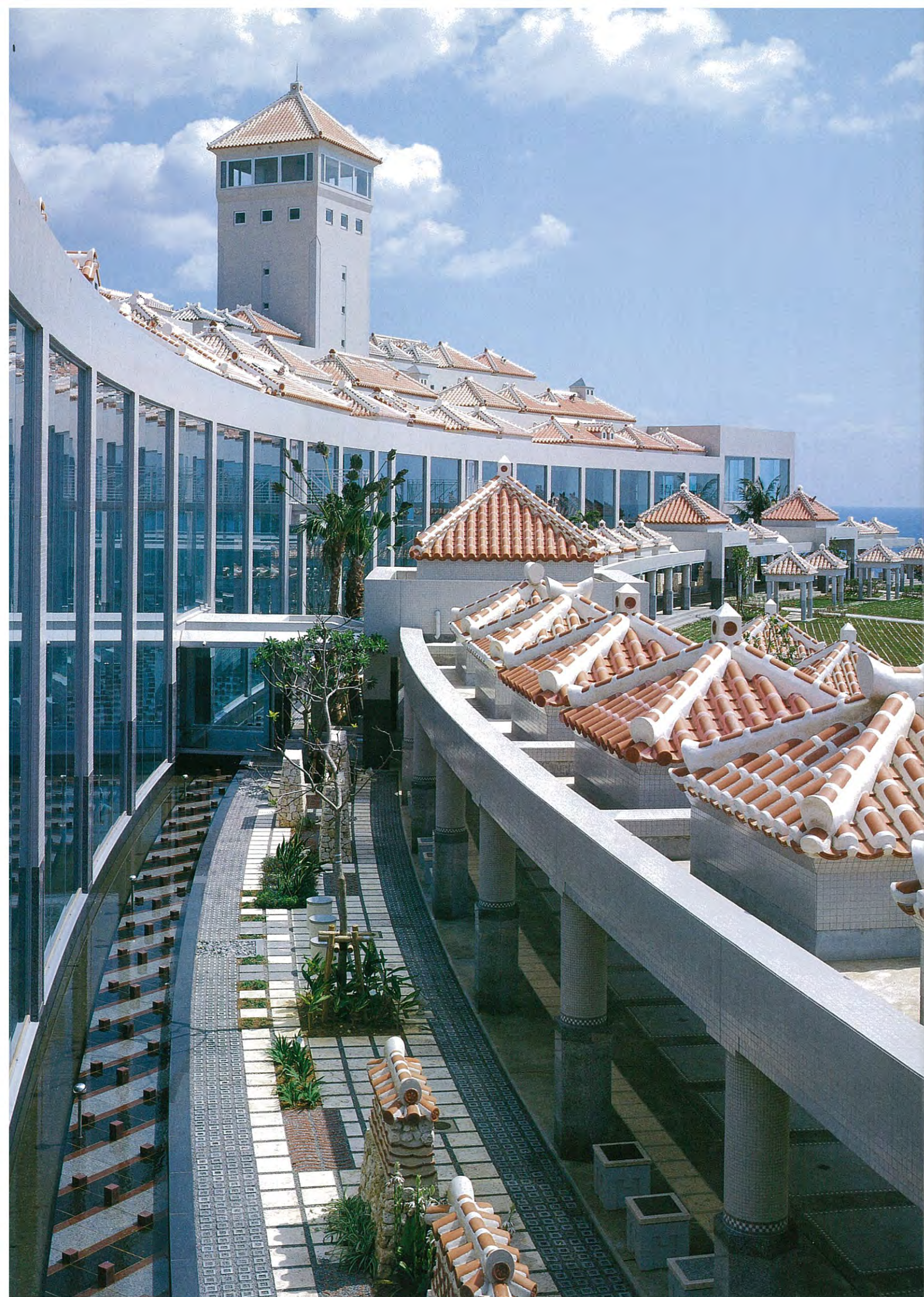
建物前面の長い柱廊。幅員4,000mm、天井高2,400mm。雨がなく陽射しの強い沖縄では大切な半屋外空間。／198-199頁：「平和の礎」側の全景。建物全長は217mあり、「平和の火」中心として同心円を形成する配置となっている。／左頁：建物と柱廊の間の中庭。ここには水路、ヒンプン、敷瓦、ベンチ、井戸、東屋、草花、樹木などのさまざまな沖縄の要素が並んでいる。
