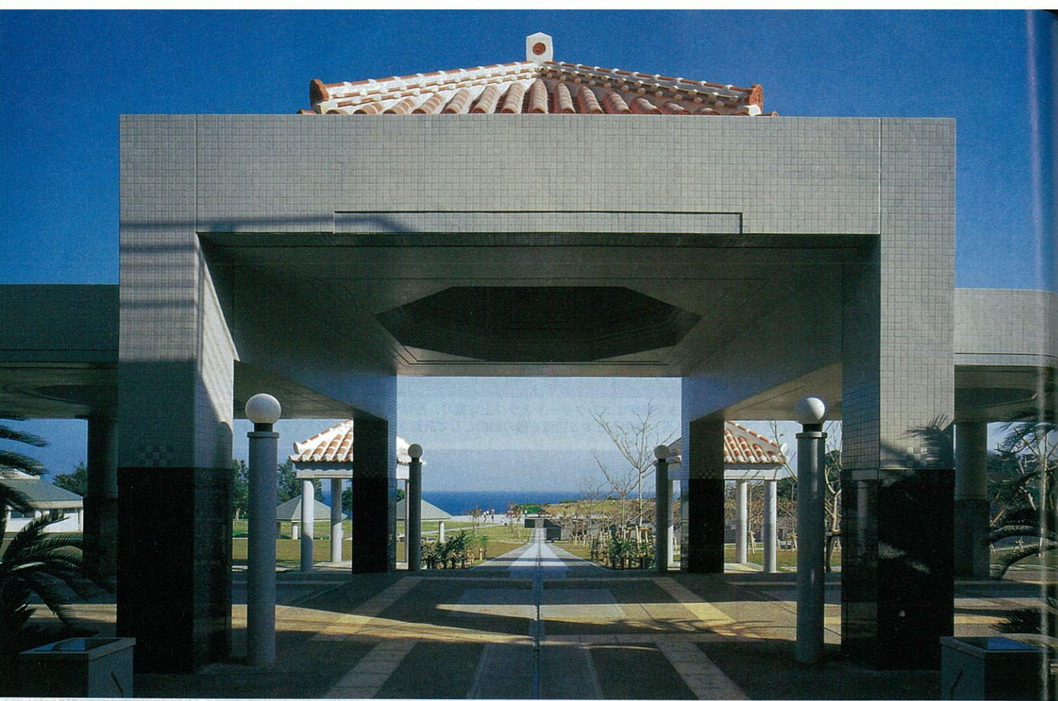
柱廊から平和の礎の中心にある「平和の火」を望む。建物の外壁には細目地の47mm角モザイクタイルを貼って塩害対策を施した。色調も抑えている
