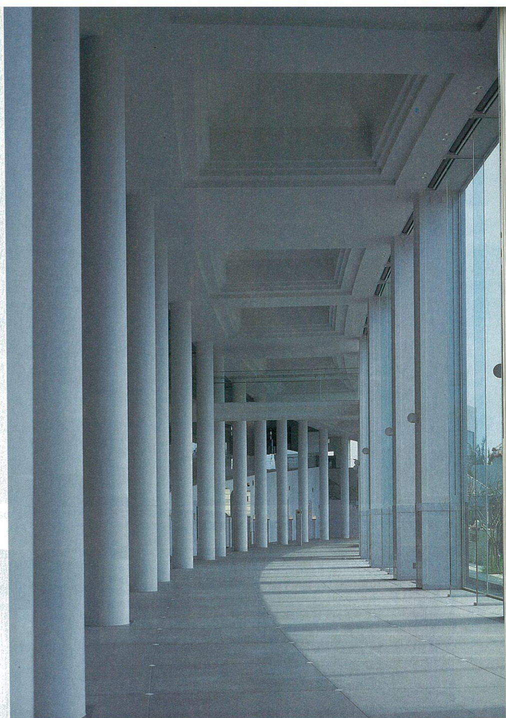
ホール南側の回廊（1階部分）。赤瓦屋根のトップライトから光が降り注ぐ。来訪者の視線は開口部を通して自然に円盤の中心にある平和の礎と向かう。中庭側の3カ所からも回廊に自由に入ることができる
