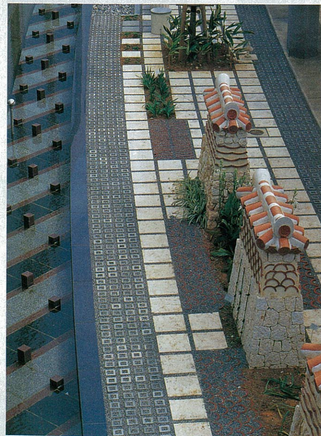
仕上げに最も凝った中庭部分の俯瞰。左は池。白く見える敷石は琉球石灰岩
