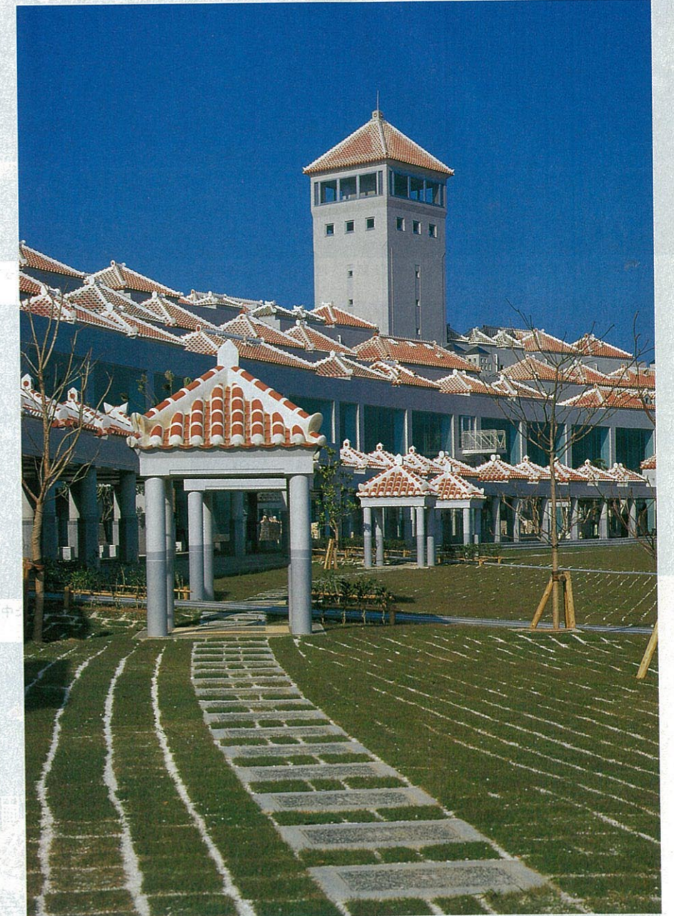
展望階のある塔は設計者のオリジナル提案。漆喰で固めた赤瓦の色は眺める角度で微妙に変わる
