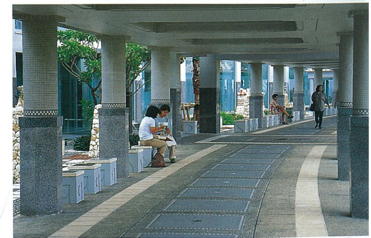
柱廊は、強い日射しやわか雨から人々を守る伝統的な沖縄の雨端(縁側)空間。数多くのベンチが置かれている
