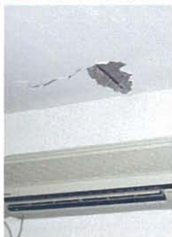
▲◀資材の品質管理やメンテナンスが不十分で、建物の外観や屋内にはクラックが走っている。コンクリート片の落下などで危険な状態
