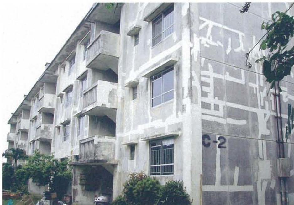
▲◀資材の品質管理やメンテナンスが不十分で、建物の外観や屋内にはクラックが走っている。コンクリート片の落下などで危険な状態
