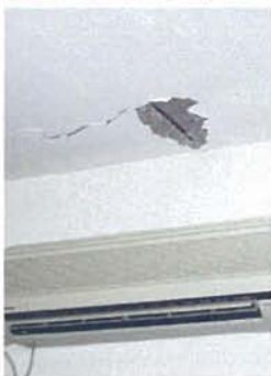
▲◀資材の品質管理やメンテナンスが不十分で、建物の外観や屋内にはクラックが走っている。コンクリート片の落下などで危険な状態
