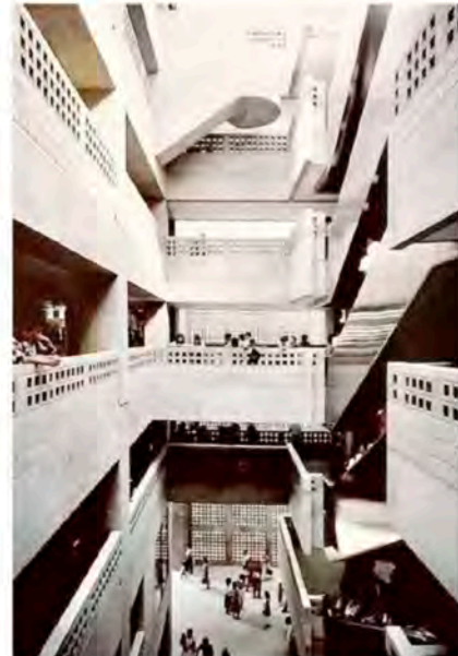
建物中央部の「光の井戸」の吹き抜け部分。屋根がなく、外部の光や風や雨が入る (写真/ワキ ヒロミチ)
