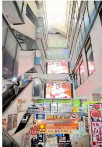
現在の中央部の吹き抜け。改装された手すり部分に大型スクリーンや雑多な看板などがある。上部にはテント屋根がある
