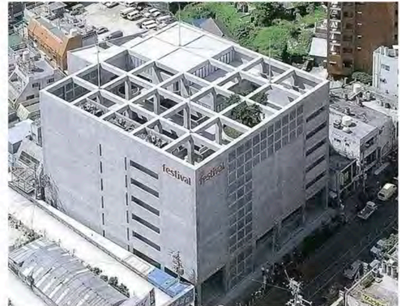
フェスティバルビル当時の外観。建物は36mの立方体、均等スパンのラーメン構造、外壁は20角の型枠コンクリートと花ブロックで、内外とも打ち放し仕上げだった。沖縄の気候風土を考えた建築家安藤氏の力作 (写真/ワキ ヒロミチ)
