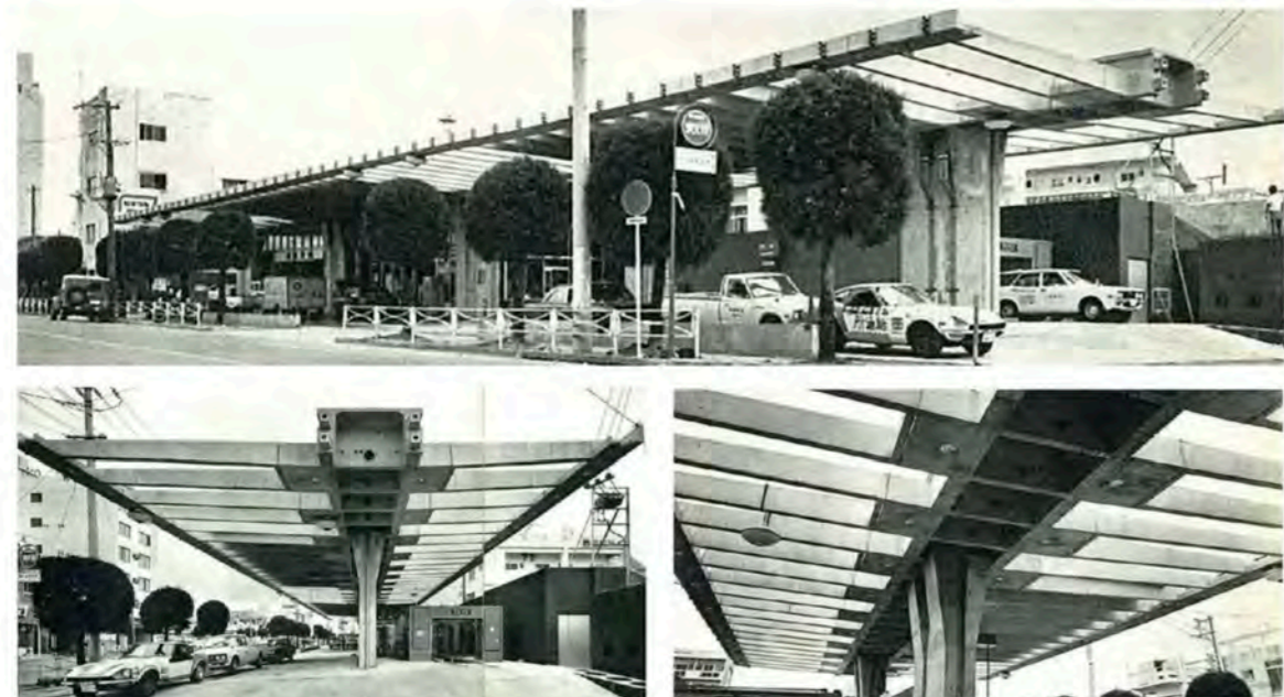
上/那覇西給油所 建築家・仲宗根宗誠との協働。施工精度が高く塩害に強いPC構造デザインによって沖縄らしい半戶外空間が生まれた。下左/柱から跳ね出したPC梁やルーバー部材から成る大きな屋根。下右/柱とPC梁とルーバーの納まり詳細。(写真/新建築)
