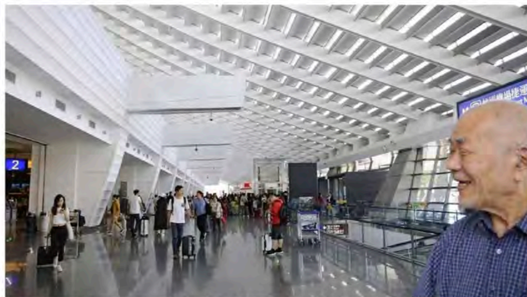
台湾桃園国際空港。建築家・園紀彦と渡辺の協働。500万人想定空港を3倍に増やしたため外部を内部化する改修工事を手掛けた。カタナリー状鉄骨+PCルーバー型構造。2017年台南市コンベンションセンターコンペのため筆者と訪れた際の一枚。右が渡辺
