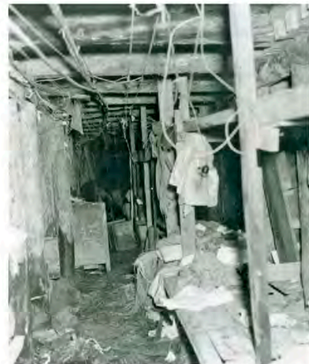
首里城地下の第32軍司令部壕。地下15~33m、全長約1000m、約1.8m角の湿気と湧き水と空気の悪いこの壕で日本軍は沖縄戦の作戦をたて、命令を出した。(沖縄県公文書館)
