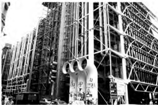
▶裏側の外観。カラリングされた露出の設備配管が並ぶ
