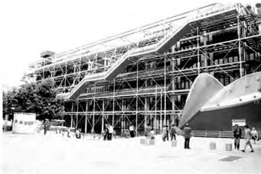
▲ポンピドゥーセンター広場側の外観。エスカレーター、エレベーター、階段などの動線スペースがあり、建物の主要構造物の柱や建物の揺れを防ぐ細い対角ブレースが見える
