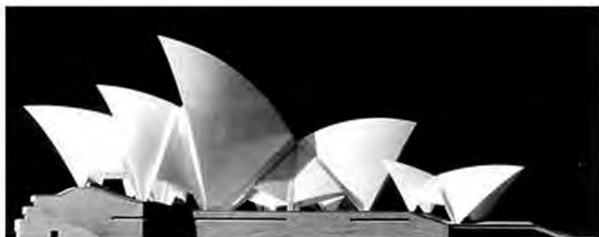
シドニーのオペラハウス。当初、当時全盛期だった薄いシェル構造でつくる予定であったが、コストの問題などにより着工が遅れた。その後、構造家オプ・アラップの提案により屋根デザインを球面に変更し、PC構造に変更し完成
