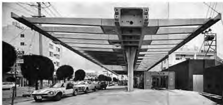
那覇市西町にあった給油所。建築物というより巨大なパーゴラ式構造物(約60メートル×13メートル)で沖縄特有の光と陰を演出する。塩害地域である沖縄にとって、高密度・高強度のPCこそ構造建材として最適
