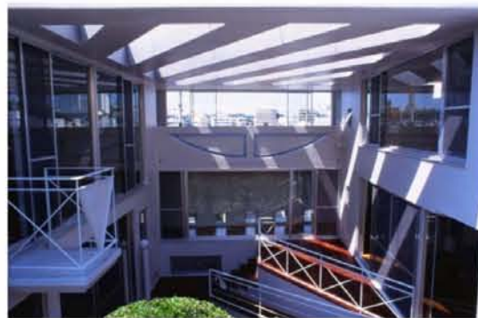
右上の住宅の中庭空間。周囲の個室は中庭に面して大きなガラス窓が設けられており、やわらかな光や涼風が入ってくる
